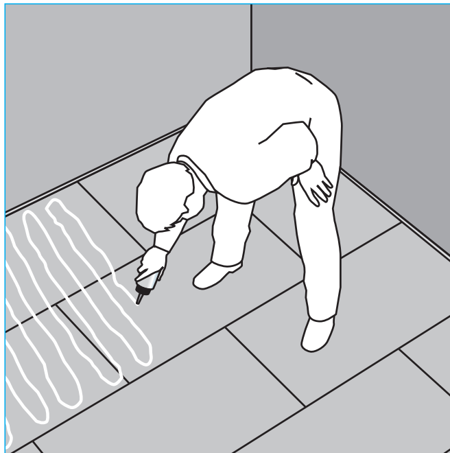
Nakładanie kleju AQUAPANEL® Slot Adhesive (PU) i AQUAPANEL® Joint Adhesive z zachowaniem odstępów ok. 10 cm między wałeczkami kleju
